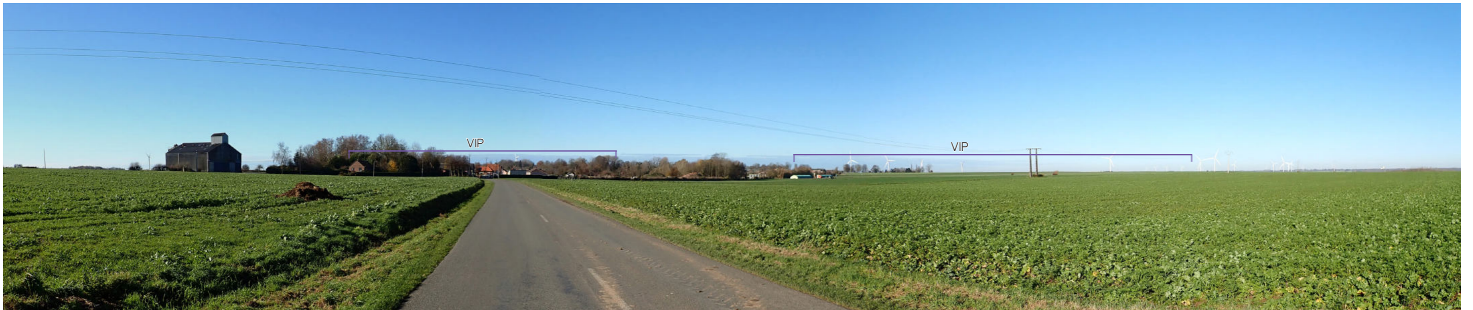
Photo 54 : Depuis la RD 115, la partie sud du VIP est tronquée par la végétation et la bâti du village de Bonnières ; la partie nord du VIP est pleinement visible, intégrée dans le motif éolien
