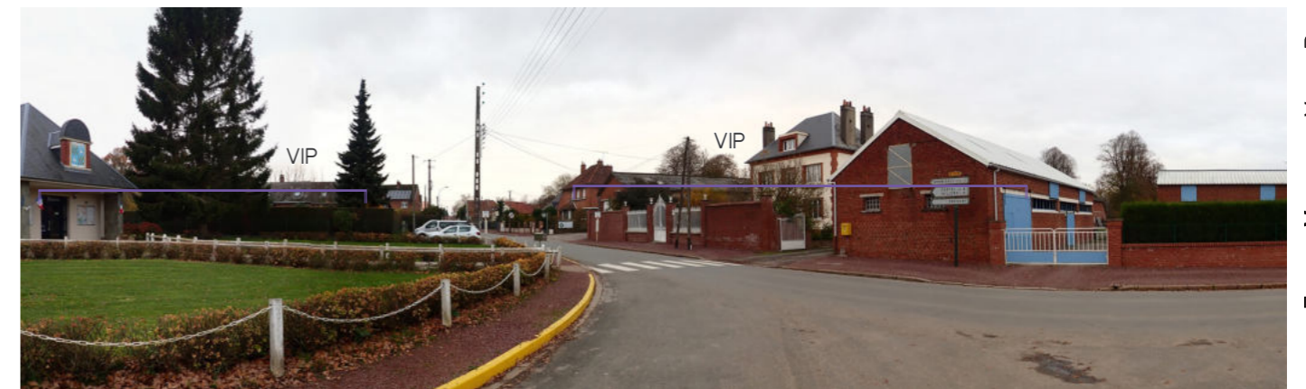
Photo 71 : Depuis le centre bourg, le VIP est masqué par la trame bâtie
