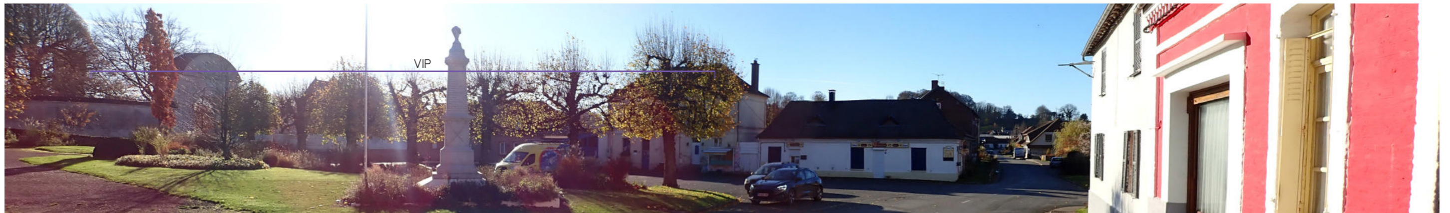
Photo 58 : Depuis le centre bourg, les vues sont limitées par le bâti proche et la végétation
